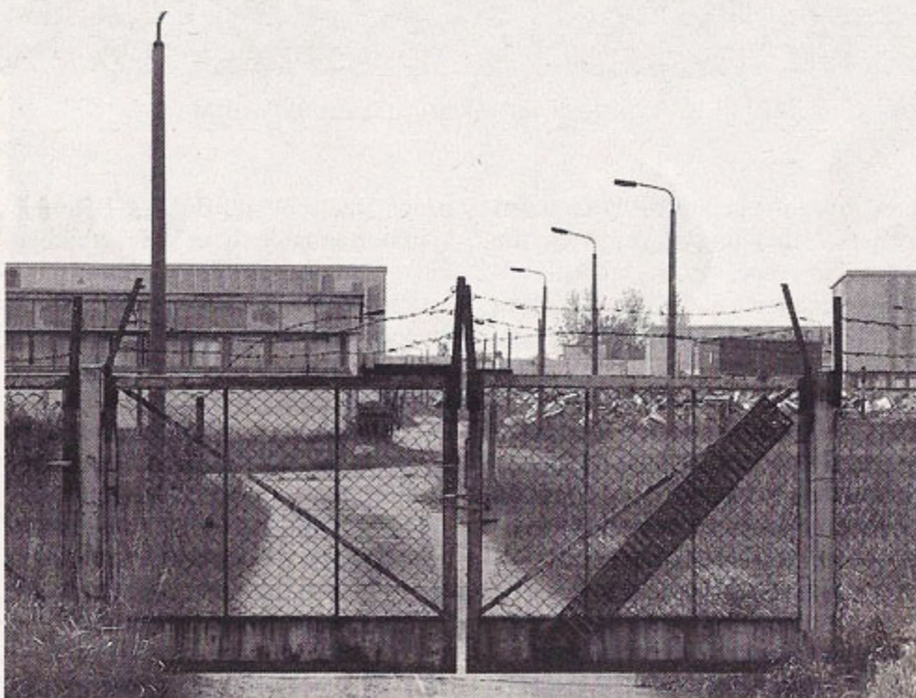
Eingangstor zur Anlage Haßleben
